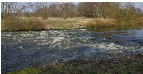
Jez č. 4: Petrovičky, stupeň z kamen. shozu, ř. km 22,8;
